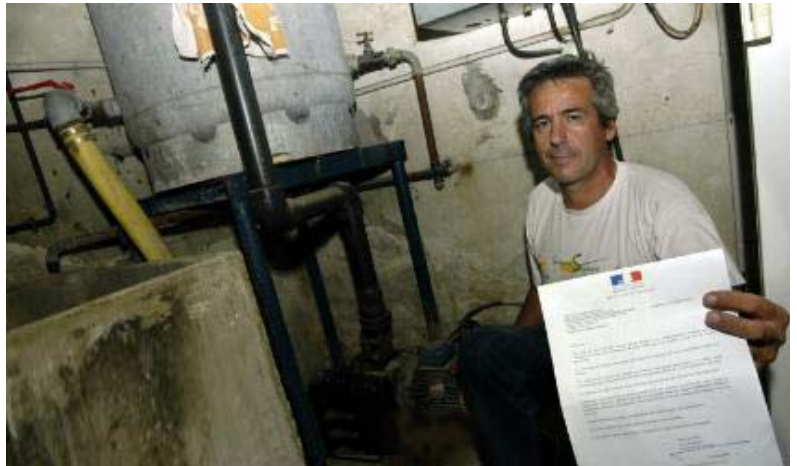
Pascal Reynaud vient de recevoir un courrier de la préfecture lui conseillant de ne pas boire l'eau de son forage.
