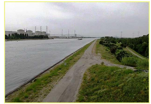
Digues de la surélévation du canal de Donzère-Mondragon face à la prise d'eau de refroidissement de la centrale nucléaire du Tricastin
