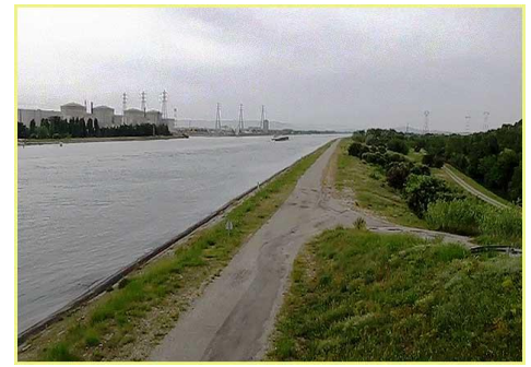
Digues de la surélévation du canal de Donzère-Mondragon face à la prise d'eau de refroidissement de la centrale nucléaire du Tricastin
