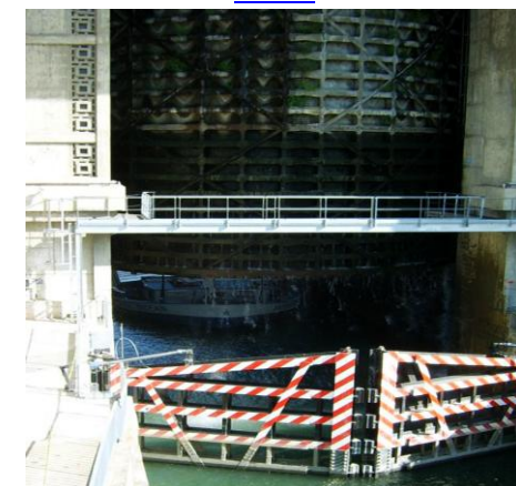
Vue porte amont de 24 m de haut de l'écluse
