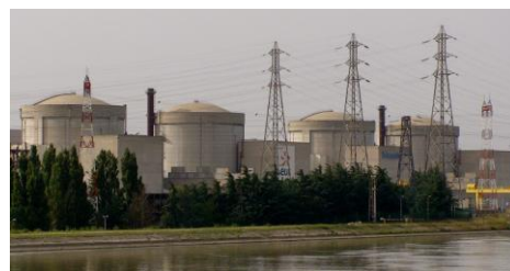
Les 4 réacteurs du site nucléaire EDF du Tricastin.
