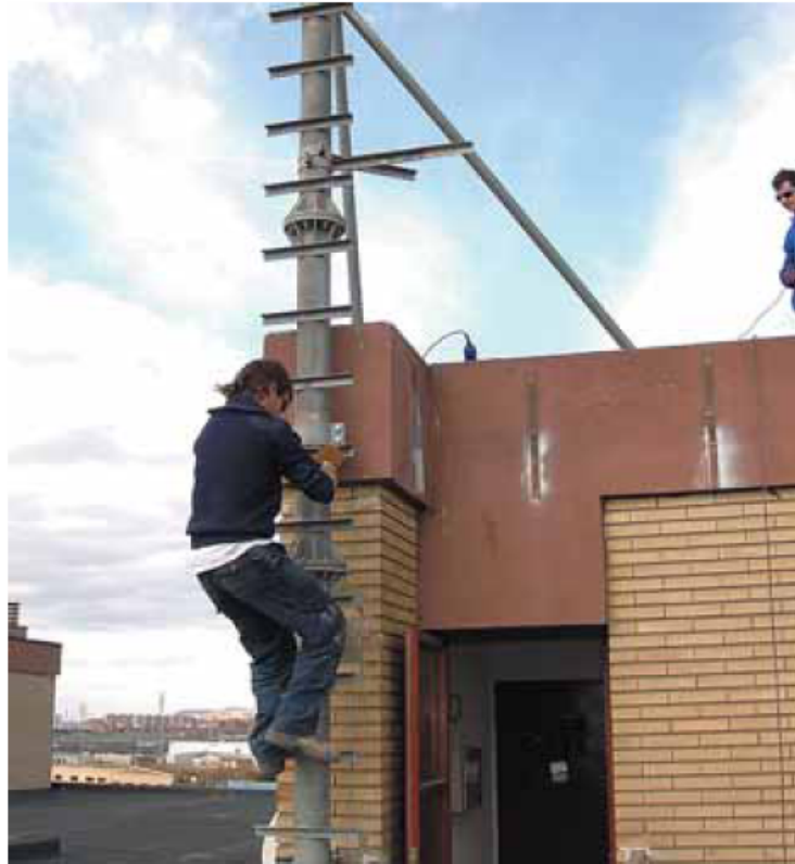
Junto a la antena retiraron una caseta anexa de unos 12 metros cuadrados.
