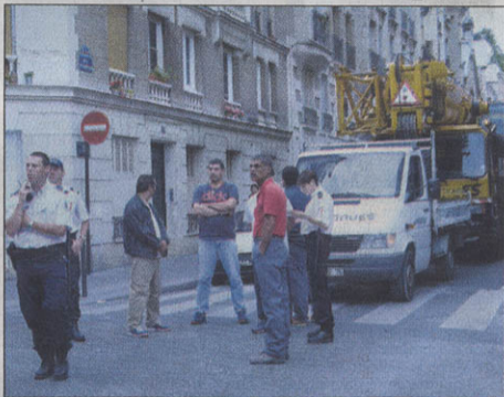
PARIS, RUE SIMPLON, HIER, 8 HEURES. Des habitants sont descendus pour empêcher les travaux préparatoires à l'installation d'une antenne-relais. (DR/HELENE BARBIER DU VIMONT.)
